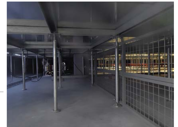
Ein Beispiel für eine Gitterabtrennung zwischen dem Gebäudeboden und dem Computerboden.
